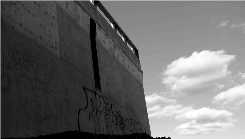
FIGURE 7 – Nouvelle section en chantier, 2016.
