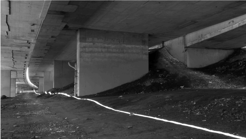
FIGURE 2 – Les dessous d'une bretelle de l'autoroute 720, à la limite nord de la Petite-Bourgogne, 2016.
